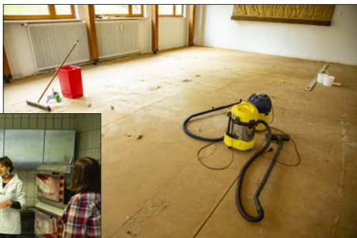
Erneuerung des Fußbodens im Raum Franziskus
