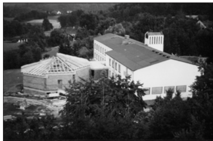
1982: Bau der Franziskuskapelle
