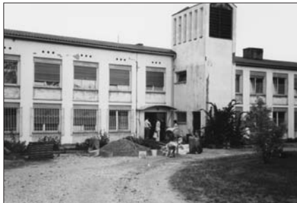
Haus der Stille 1979: erste Umbauten
