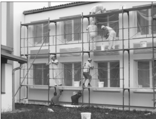
Fenstertausch und Fassendämmung (2010) rechts: die neue Heizungsanlage (2012)
