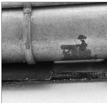
erste Schäden an den Dächern sind sichtbar
