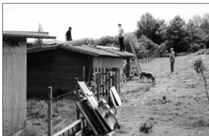
Arbeiten an der Errichtung einer Poustinia
